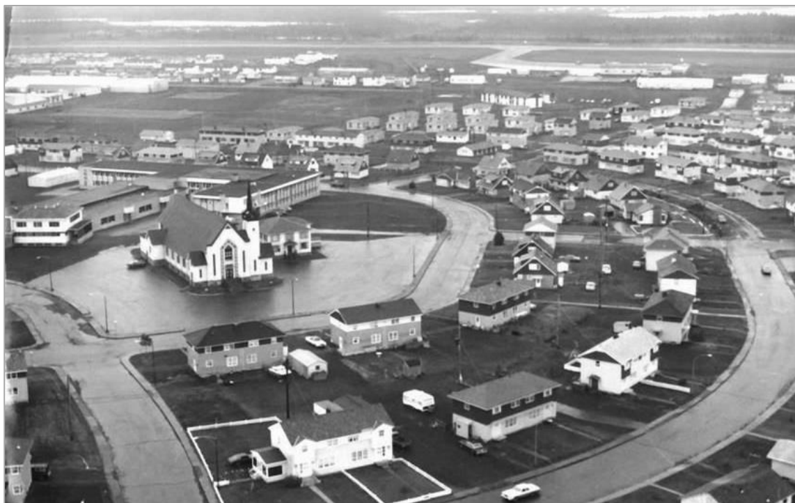
Photo 1 – Vue aérienne de Schefferville vers 1975 23
