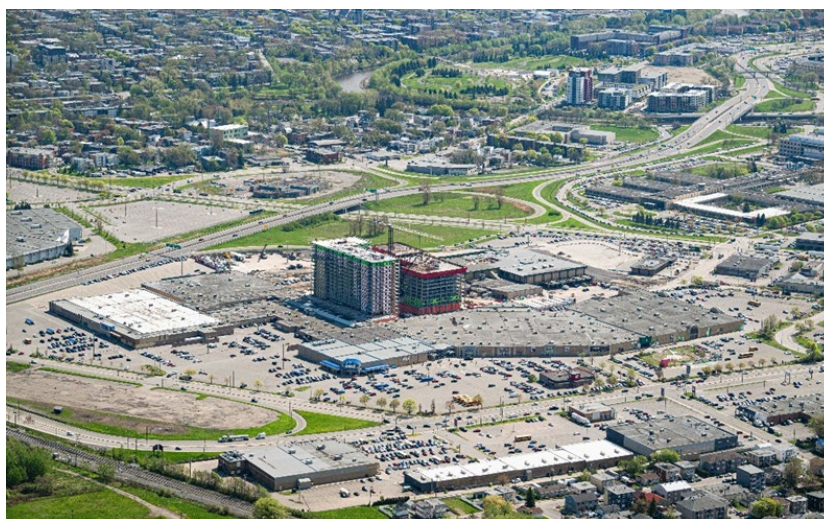
Figure 4 – Place Fleur de Lys en chantier (septembre 2024) Source : Pierre Lahoud, 2024
