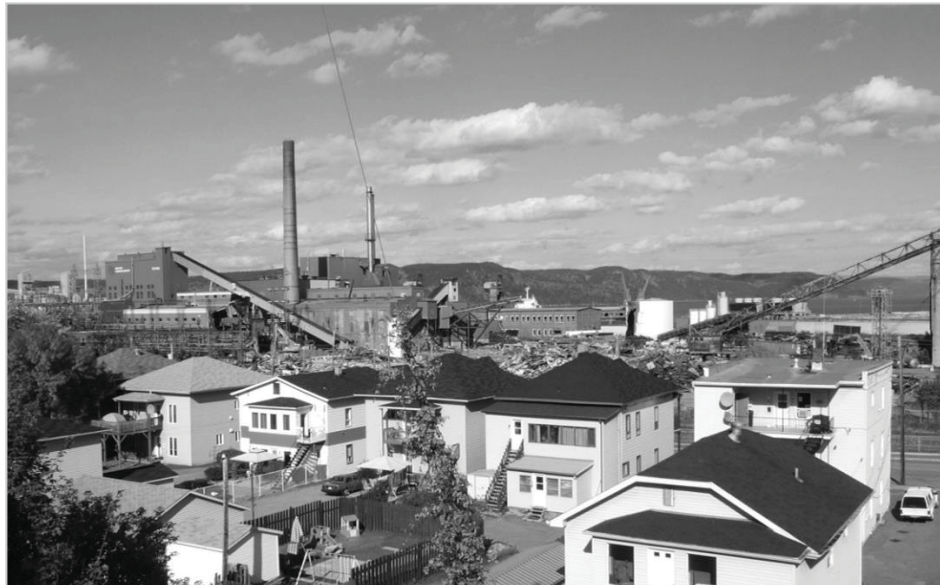
Figure 4 – Démolition de l’usine de l’Abitibi-Consolidated en 2006 (Arrondissement de La Baie) Source : Martin Simard
